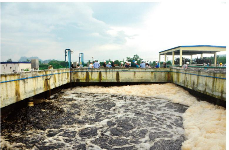
运用了韶钢项目的IBR一体化生物反应器技术，将传统A/O法的三池通过特殊结构结合，单个池子就能完成整个A/O+澄清工艺。结构的特殊性，使IBR系统能够帮助客户节省占地一半以上，并且能有更高的活性污泥浓度，在总氮去除和高难度废水处理上相对常规的活性污泥法更具优势，并且在操作和维护上更简便更受客户欢迎。当然，除了在钢铁焦化行业上已经取得成功应用外，麦王的IBR技术还适用于炼化、石化、化工、印染、制药等等工业领域，总计在全球范围内拥有超过80多个工程案例。此次会议中麦王展示了韶钢项目设计规模达到100m<sup>3</sup>/h，处理水源为典型的含酚氯的焦化废水，该项目的亮点是在有限的占地下实现COD去除率高达88-90%，氨氮去除率高达95%，总氮去除率高达92-95%的最佳处理效果。
