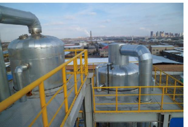
麦王承接的“包头华美稀土高科有限公司东厂环保设施综合升级改造项目氯化铵废水蒸发结晶处理系统”项目截止2015年11月23日，经过数月的安装完毕后调试，整改，试车，该项目已达产能，同时各指标达标。出厂的氯化铵成品（出盐量：32t/d）达到GB农用标准，50kg标准包装后运送化肥厂统一处理。
